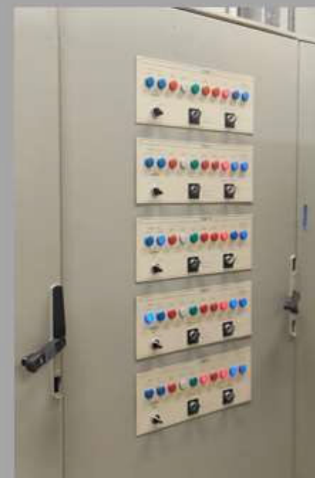
Armoire automate pilotage des serres
